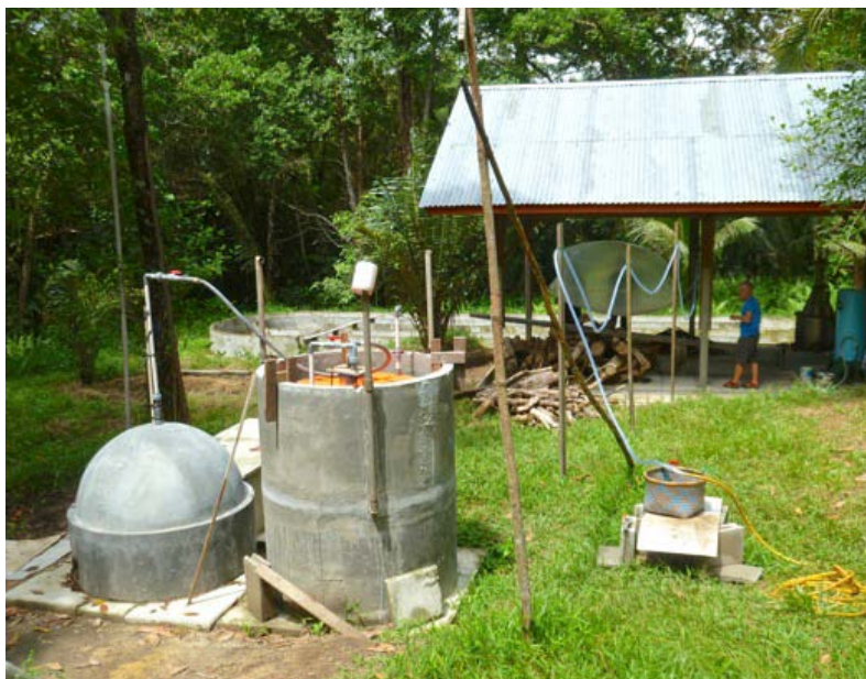
Die Demonstrations-/Trainings-Einheit für ein einfaches Village Hub auf dem Gelände von Bruder Piet. Vorne Biogas, hinten der Distiller und der Algenteich.
